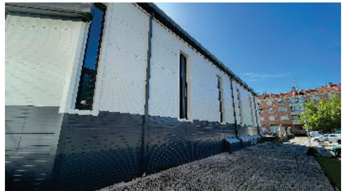
OBRAS EXTERIOR GIMNASIO CEIP VILLA Y TIERRA
