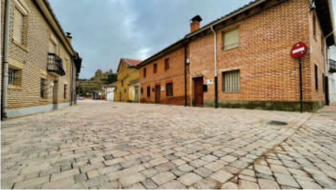
OBRA ADOQUINADO CALLE CONVENTO
