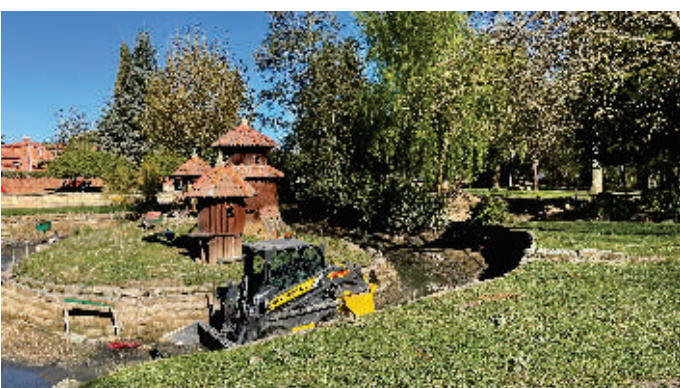
LIMPIEZA DE LODOS EN EL ESTANQUE DEL PARQUE JAVIER CORTES
