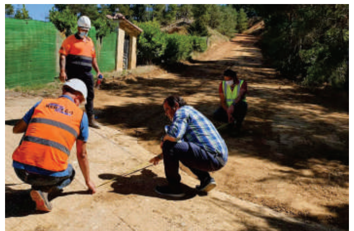
OBRA PAVIMENTACIÓN SUBIDA A VILLALAFUENTE
